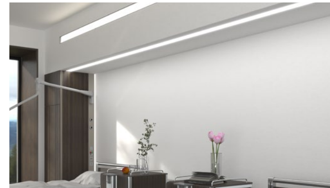
bauseitige Abkofferung mit Leuchte S 50 für Allgemein- und Leselicht
