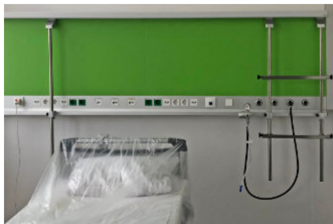
Universalhalterung »Med. Paulchen flex« (105436) mit Zusatzfixierung an Geräteschiene 25×10 mm (104099)
